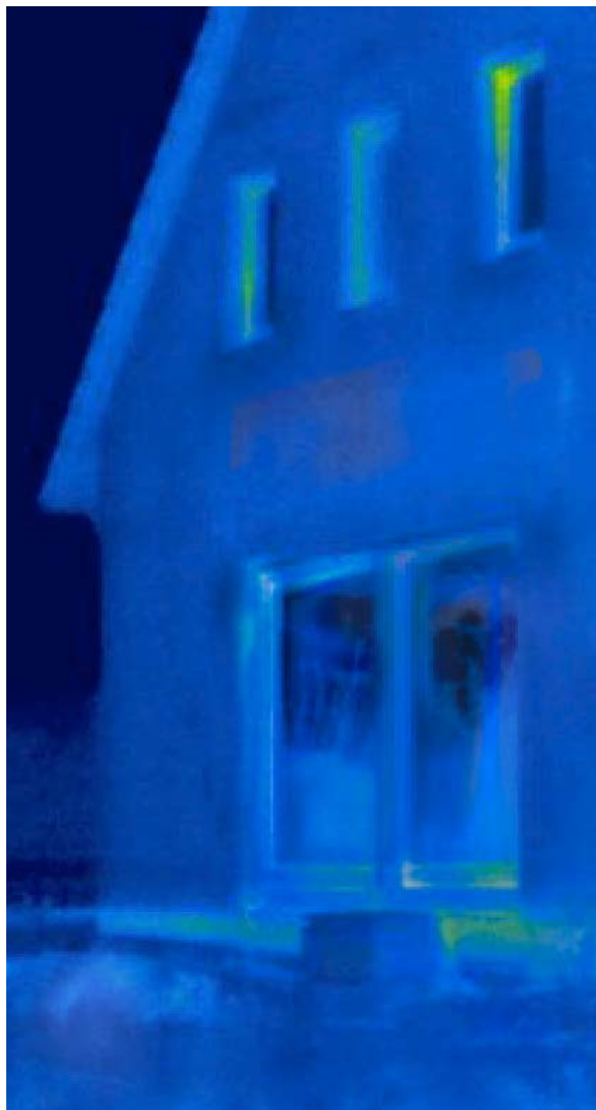
Nakon renoviranja: primena podizno-kliznih vrata GENEEO znatno umanjuje gubitke toplote.
