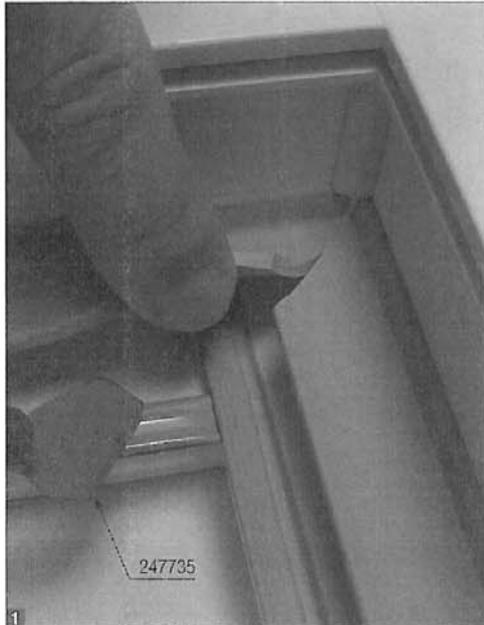
1 Schweißfuge der Mitteldichtung öffnen.
