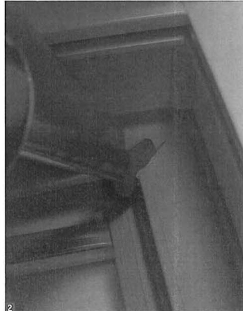
2 Die vordere Hälfte der Mitteldichtung bei ca. 400 °C ca. 3 sec. plastifizieren.
